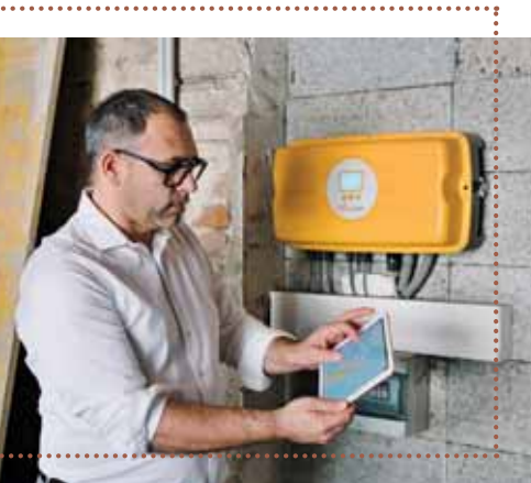
Gute Sonnenernte? Am Wechselrichter im Stadel sieht Nikolaus Reisel den Ertrag seiner PV-Anlage.
