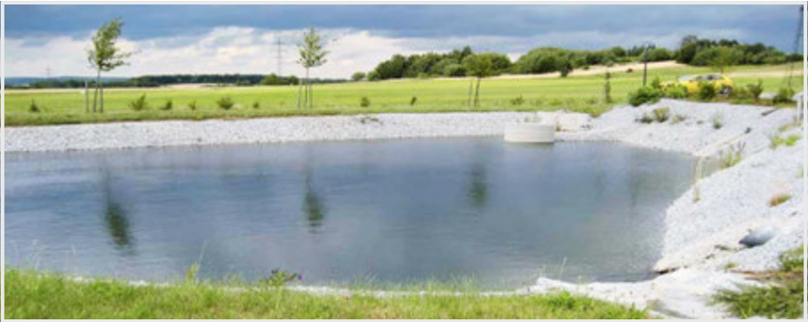
Abbildung 13 | Speicherteich zur Reduktion der Regenwasserableitung in die Kanalisation
