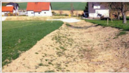
Abbildung 19 | Breit angelegte Mulde für eine kontrollierte Ableitung
