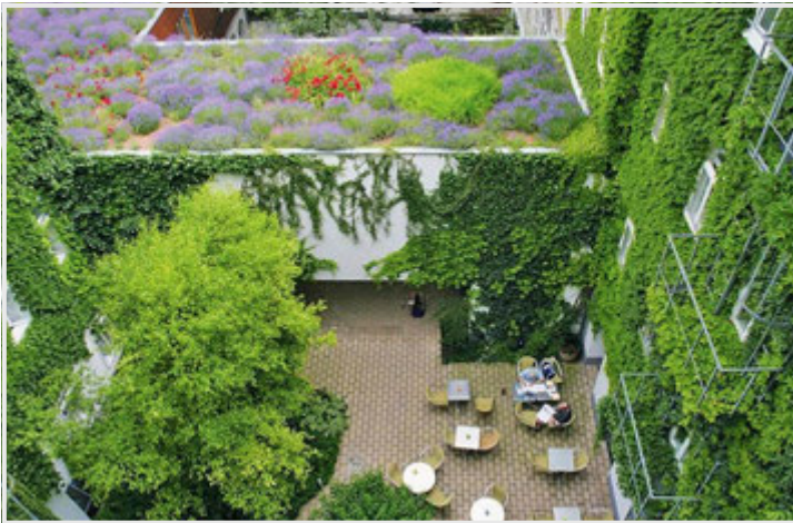
Abbildung 18 | Ansicht Fassadenbegrünung und Gründach
