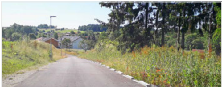
Abbildung 10 | Lineare Retentions- und Versickerungsmaßnahme durch abwechselndes Hoch- und Tiefbord
