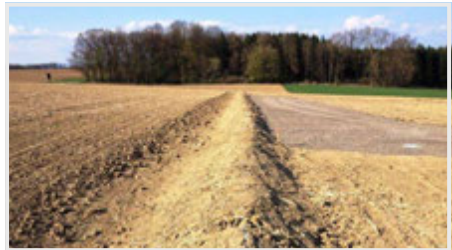
Abbildung 20 | Kleiner Erddamm zur gezielten Umleitung von Hangwässern
