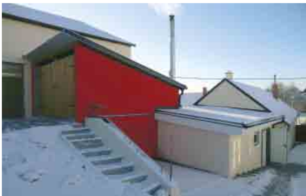
Biomasse-Nahwärmanlage Maltersbach (Gemeinde Hardegg) Copyright: Josef Fischer
