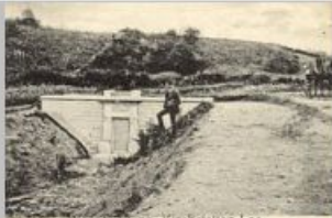
Wasserleitung Jüchenstein-Laa. Quellenfangungs-Objekt.
