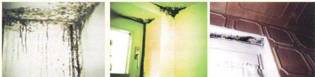
Abb. 12: Probleme der "konventionellen" Modernisierung; Schäden dieser Art sind für den schlechten Ruf von Energiesparmaßnahmen verantwortlich.
