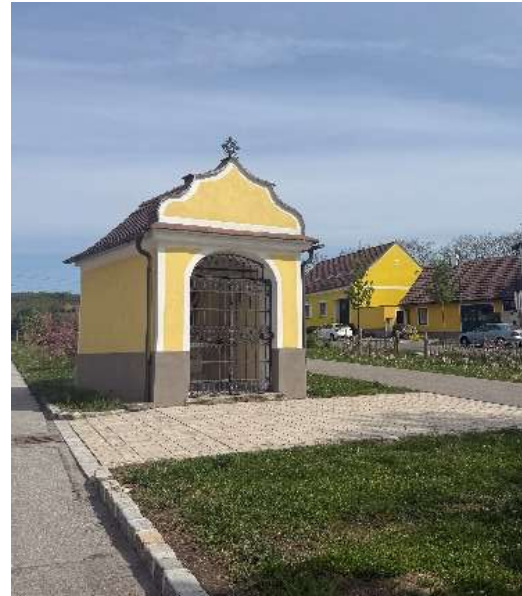
Flur-/Wegkapelle (Quelle: eigene Aufnahme)
