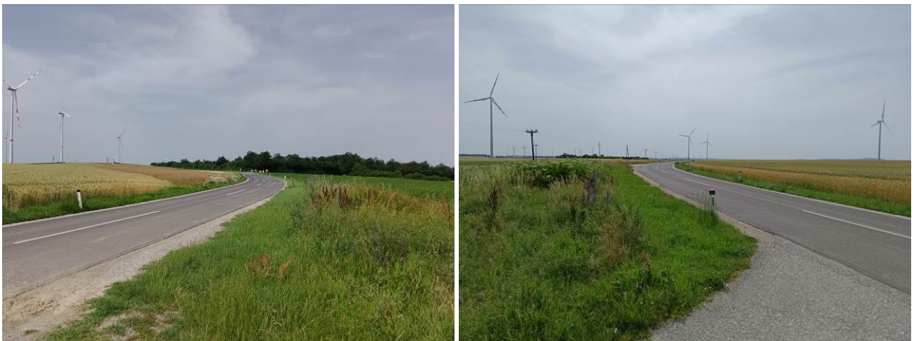
Abbildung: Sichtverhältnisse, nördliche Ausfahrt auf die L 3041 – Blickrichtung Nordost (li.) und Südwest (re.)
