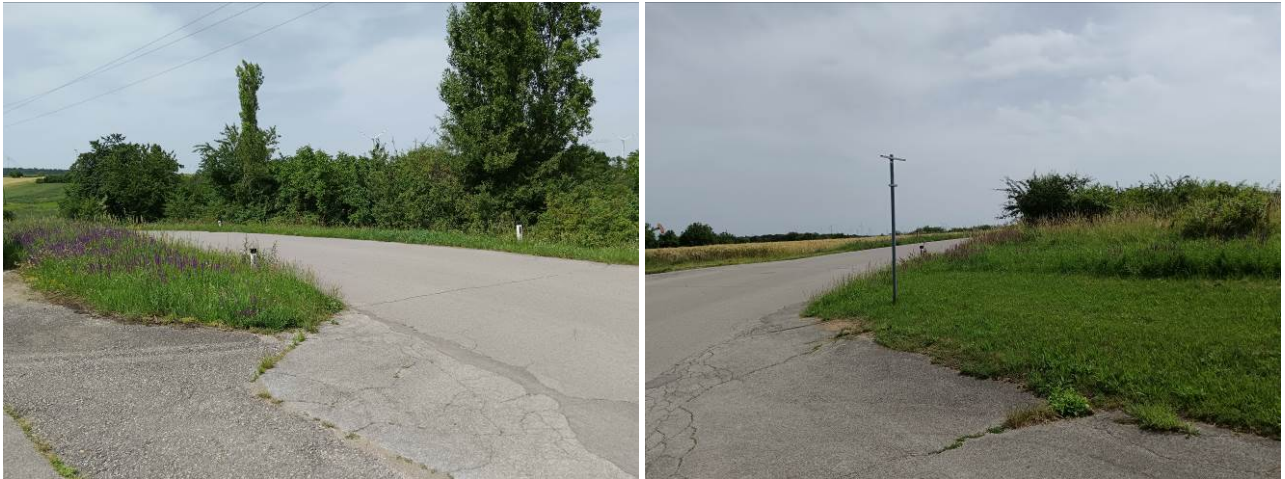
Abbildung: Sichtverhältnisse, nördliche Ausfahrt auf die L 3165 – Blickrichtung Nordwest (li.) und Süd (re.)
