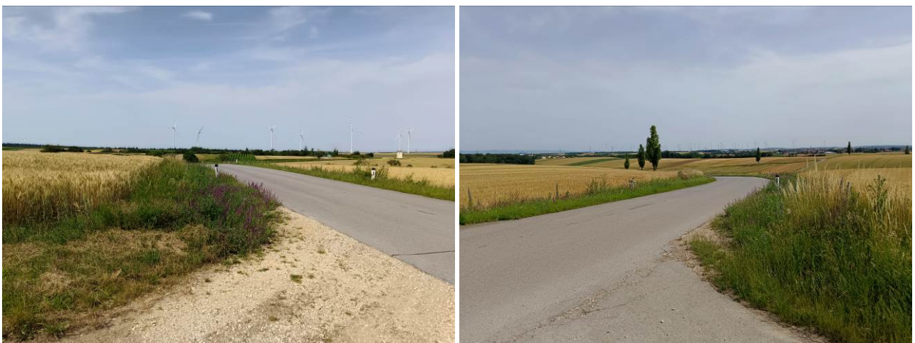
Abbildung: Sichtverhältnisse, mittlere Ausfahrt auf die L 3165 – Blickrichtung Nordwest (li.) und Südost (re.)
