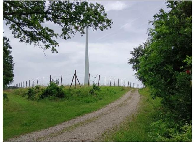
Abbildung: Zuwegung & Standort WKA 09. In der Bildmitte (linkes Foto) ist die Errichtung einer temporären Zuwegung vorgesehen, im rechten Bildrand (linkes Foto) ist ein bestehender Zufahrtsweg erkennbar.
