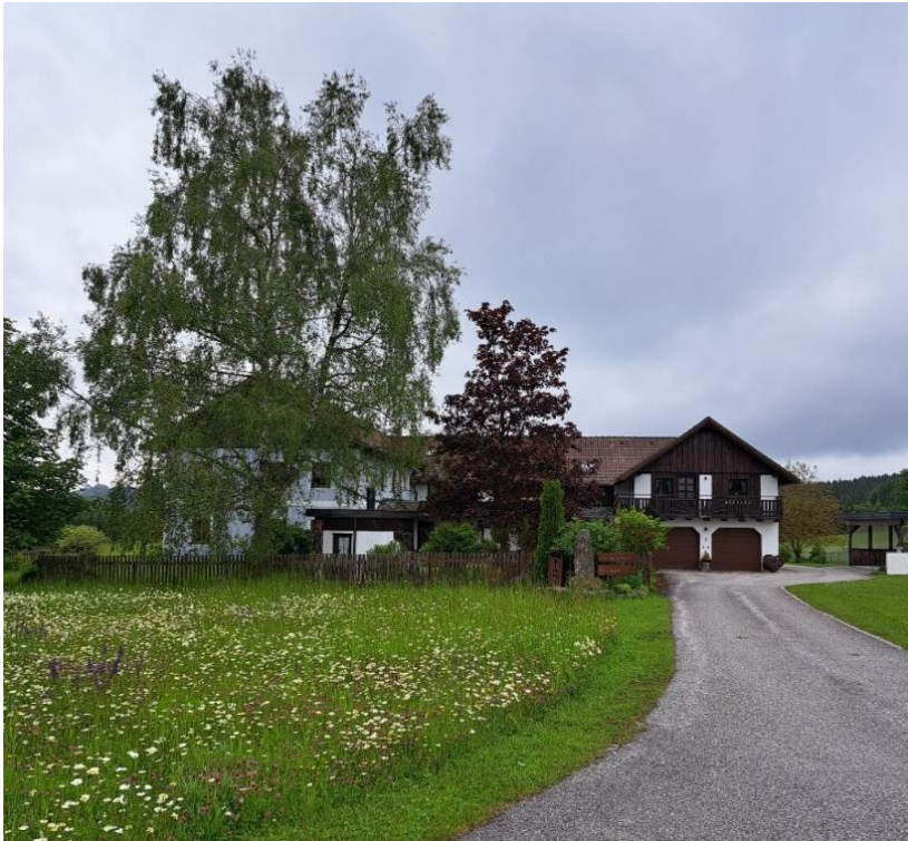
Abb. 5.14: Erhaltenswertes Gebäude im GI, IP-07
