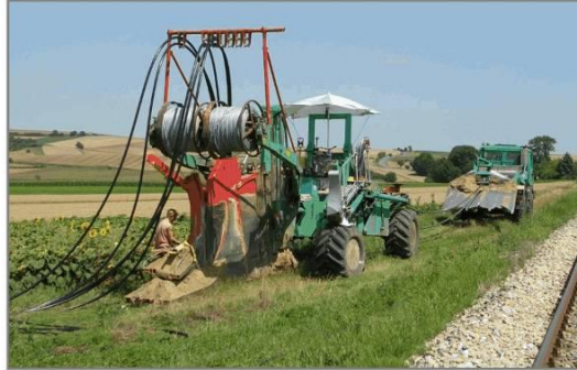
Pflug-Tross: Verpflügung mit ausgelegten Kabeln
