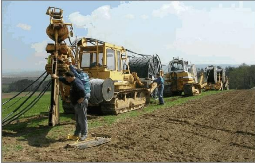
Pflug-Tross: Verpflügung direkt von den Kabeltrommeln
