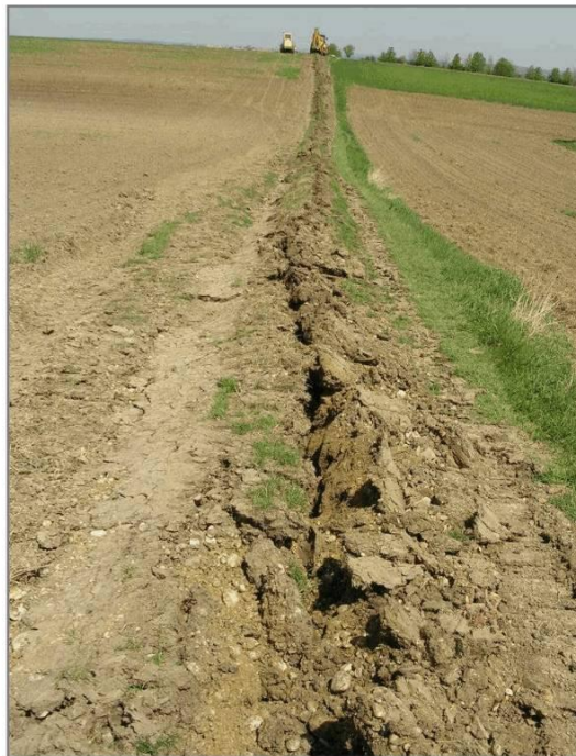
Pflugverlegung: Der Eingriff ist vergleichsweise gering
