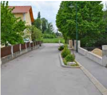
Abbildung 56: künstlich hergestellte Engstelle in einem Einfamilienhaussiedlungsgebiet
