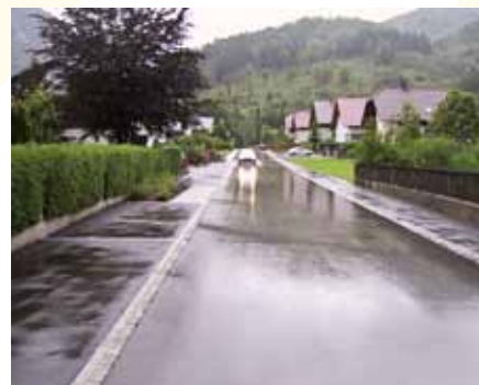
Abbildung 42: Nebenfläche in einer Siedlungsstraße zum Gehen oder Parken
