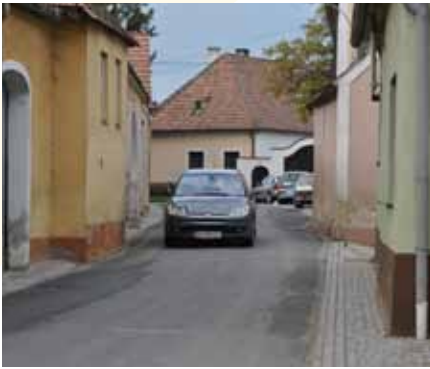
Abbildung 54: Ortsdurchfahrt mit Engstelle, eine Begegnung ist hier mit PKW nicht mehr möglich
