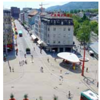
Abbildungen 9 und 10: Zentralplatz vorher und nachher www.begegnungszone.ch
