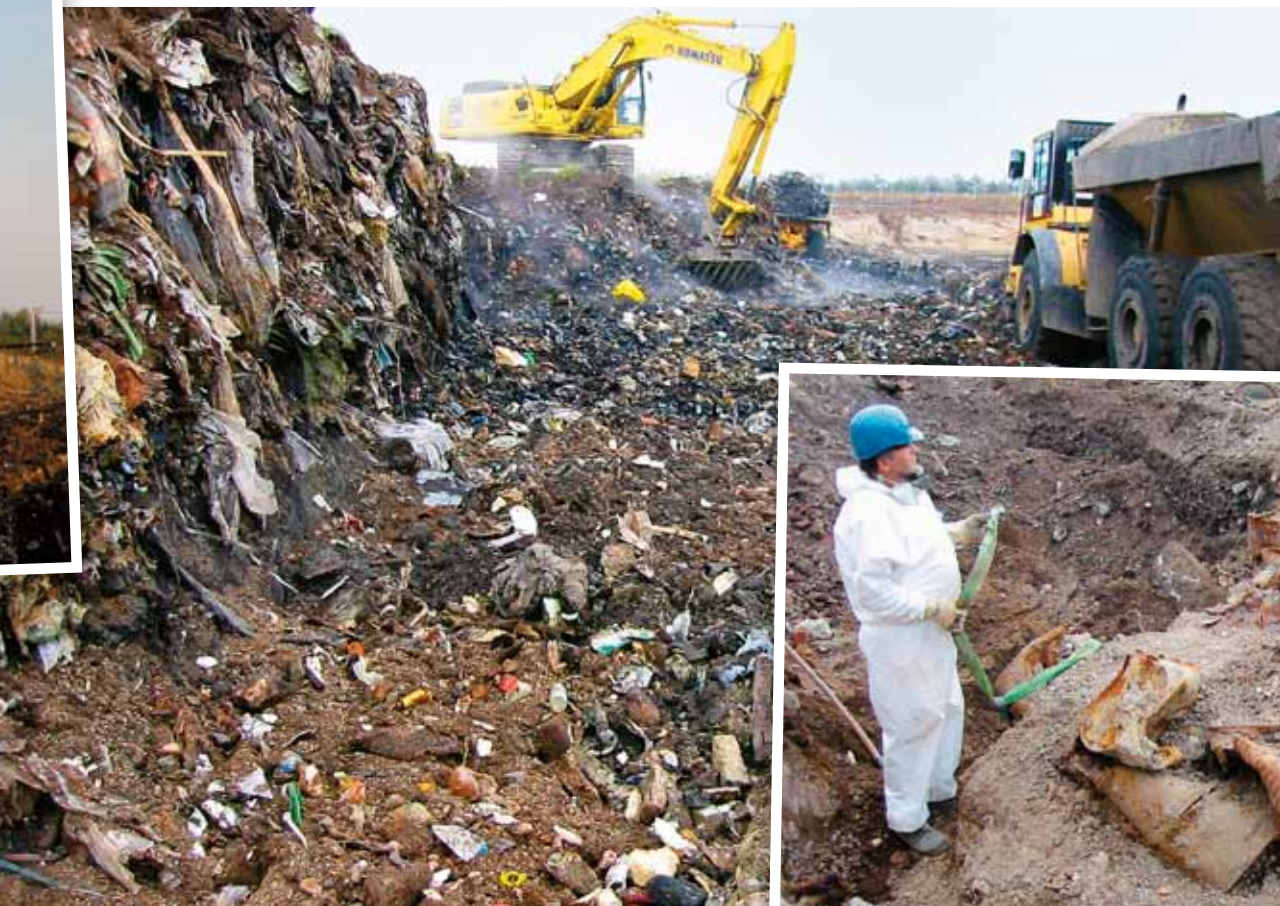
Eine alte Deponie kann auch durch Umlagerung sicher saniert werden.
