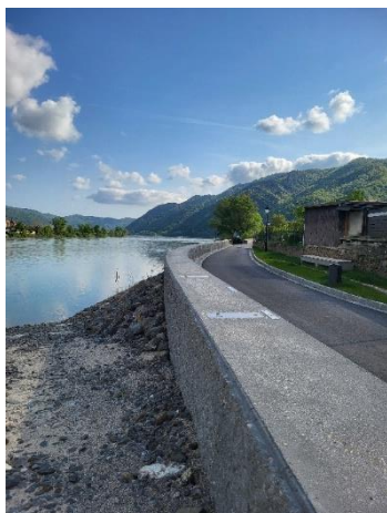
Abbildung 9: Fertiggestellter Hochwasserschutz an der Donau in Bacharnsdorf und- Mitteransdorf (2024) (C: Fachabteilung WA3)
