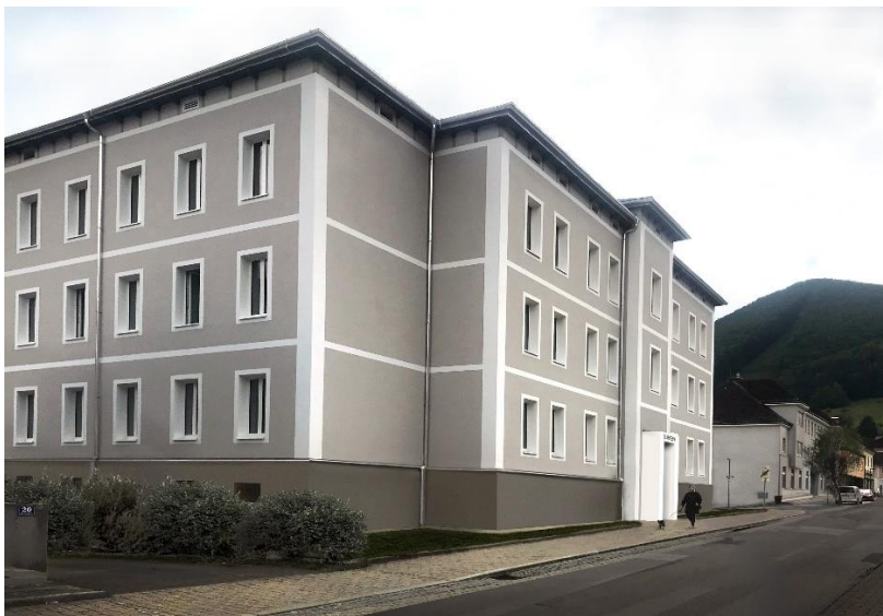
Abbildung 4: Saniertes Amtsgebäude 2 Lilienfeld, (Qu: LAD3)
