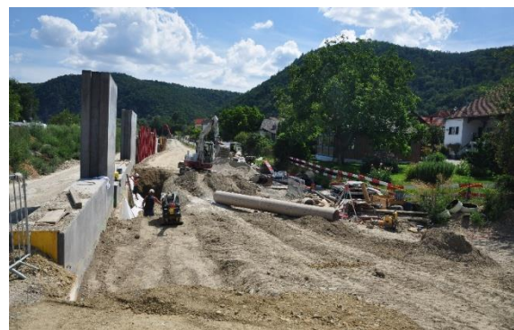
Abbildung 10: In Bau befindlicher Hochwasserschutz an der Donau in Rossatzbach (2022) (C: Fachabteilung WA3)
