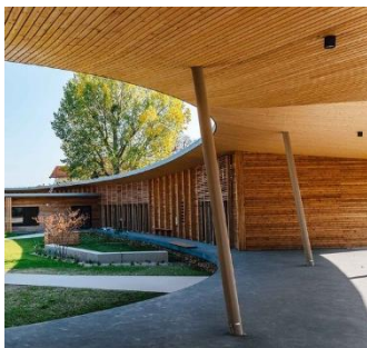
Abbildung 13: Innenhofansicht des Neubaus (Qu: Website der Graf-Holztechnik GmbH)
