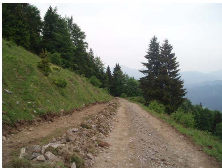
Bild 4: Vorher, anstehendes Gestein wird vorgelegt
