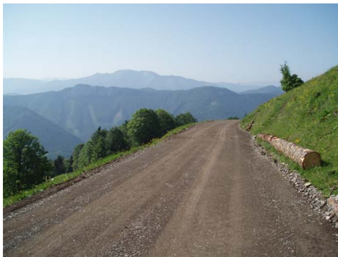
Bild 9: Fertiger Weg mit Querentwässerung
